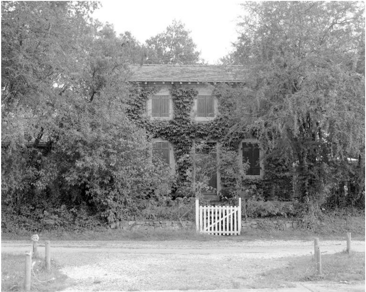
La maison éclusière
