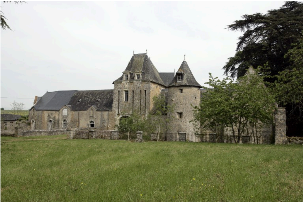
Vue d'ensemble des bâtiments ouest depuis l'avant-cour au sud-ouest.
