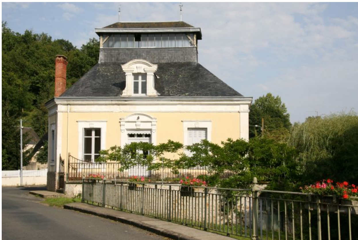
Vue d'ensemble prise du pont sur la Fare.
