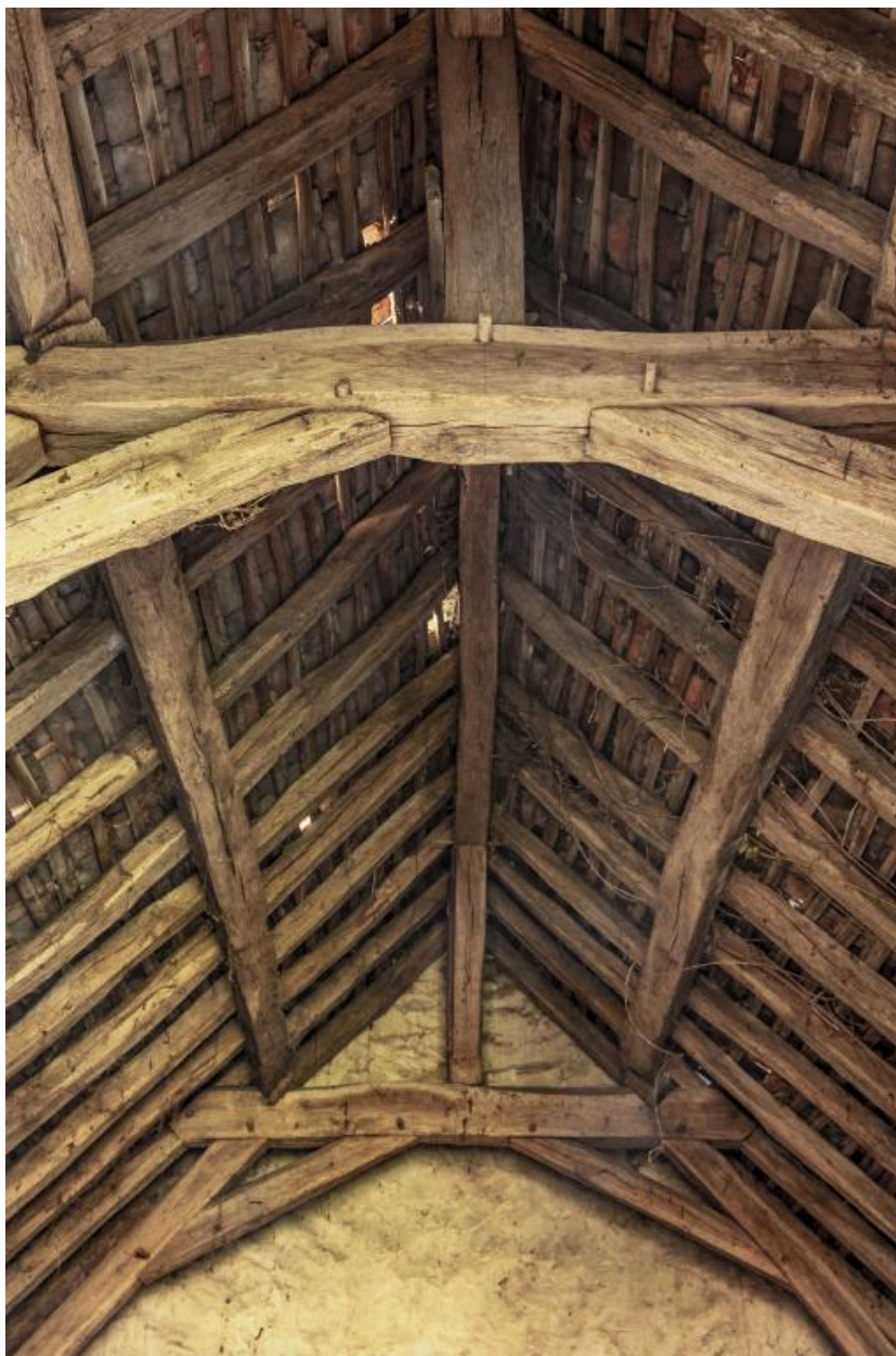
Vue de la charpente de l'appentis de la grange.
