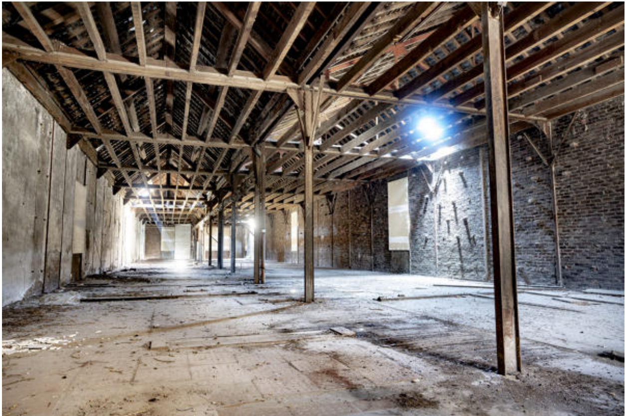
Vue du comble du bâtiment D.
