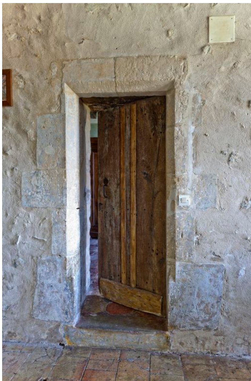
Porte de communication vers le corps accoté au pignon droit.
