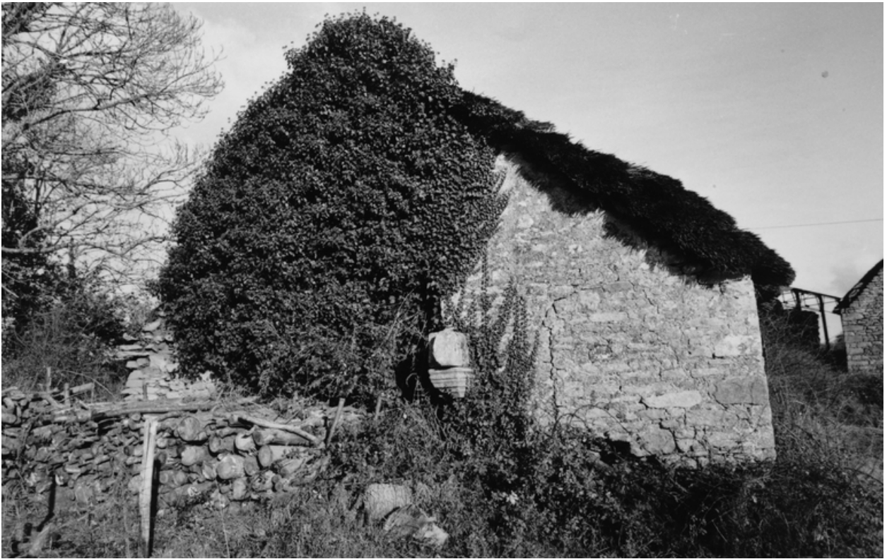
Bâtiment ouest. Logis noble (?). Vue d'ensemble depuis l'ouest. 1990.
