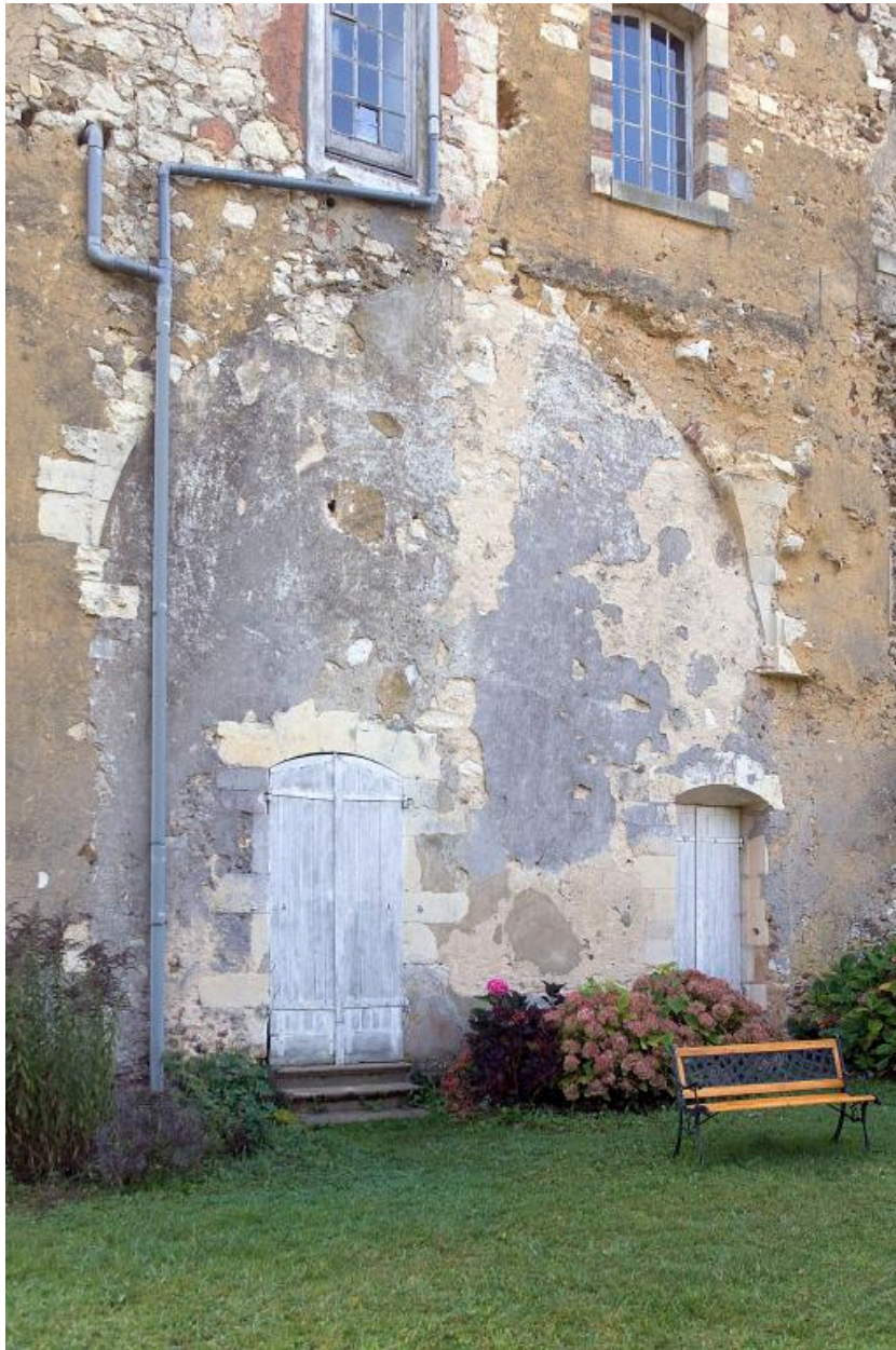
Le pavillon, façade nord, arrachement de voûte, 2007.
