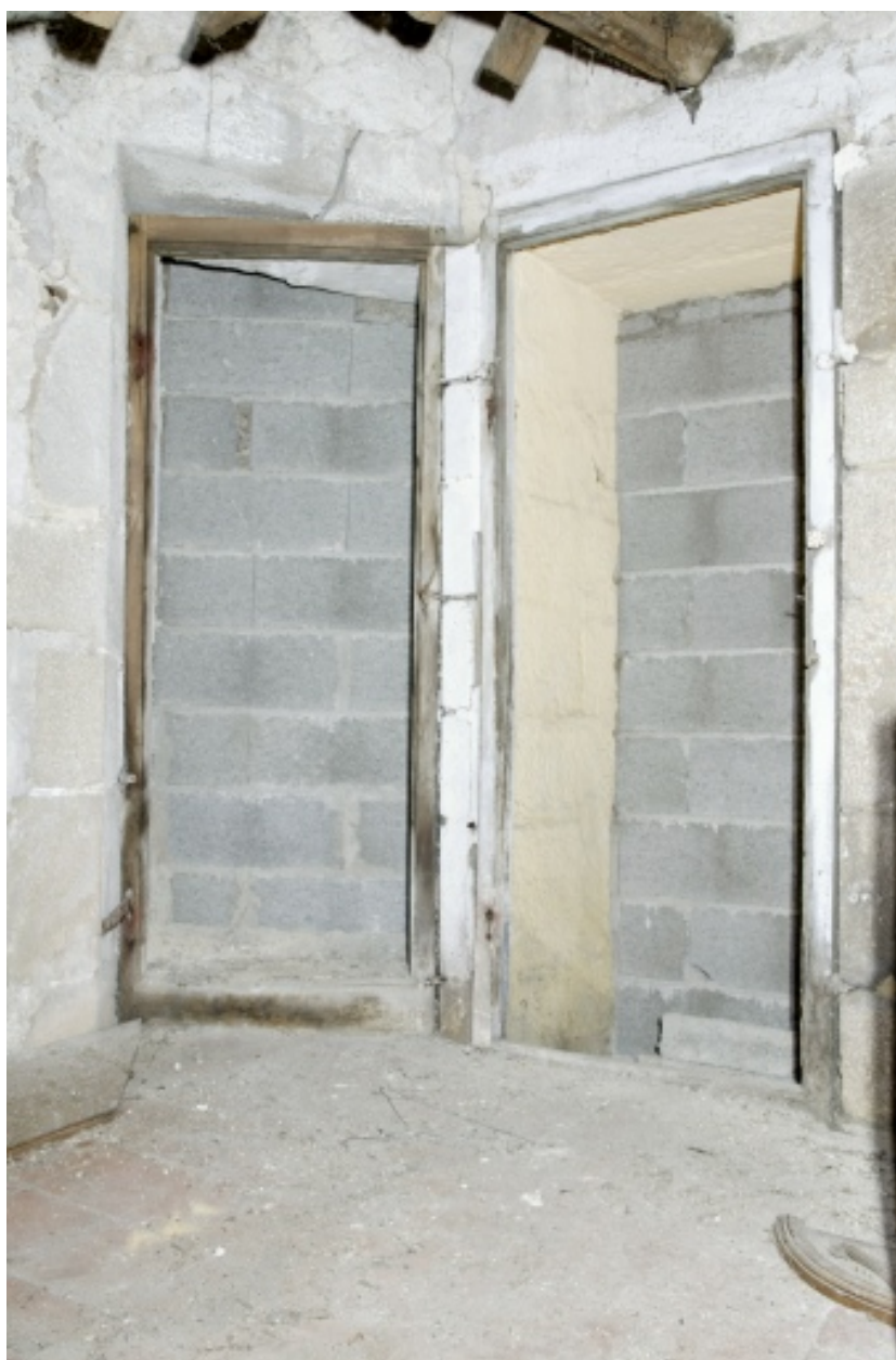
Vue du comble, détail des portes jumelles murées donnant vers l'escalier de la maison n°12 rue de Saillé.
