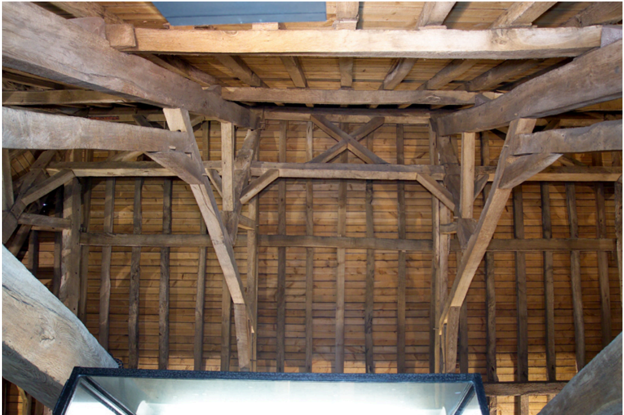
Vue de la charpente.
