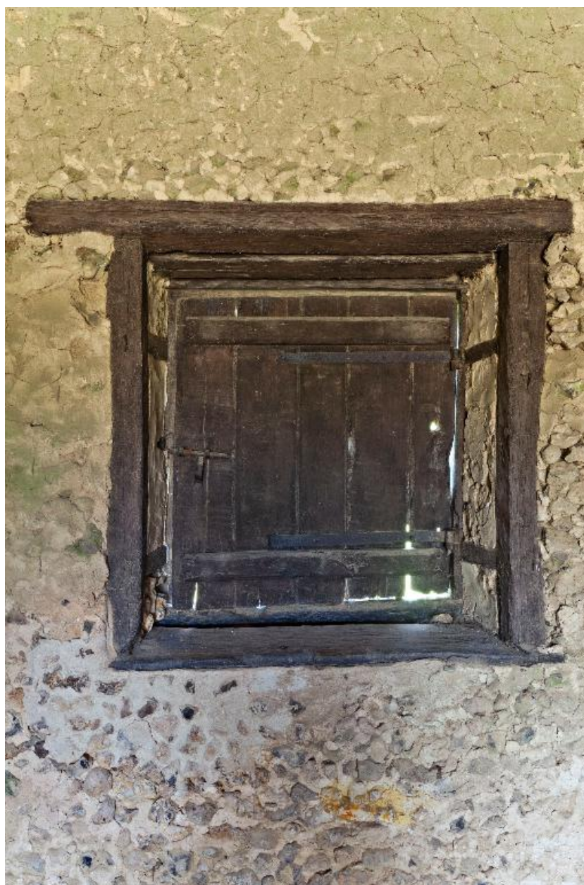
Baie à chambranles de bois de l'élévation postérieure de la grange.
