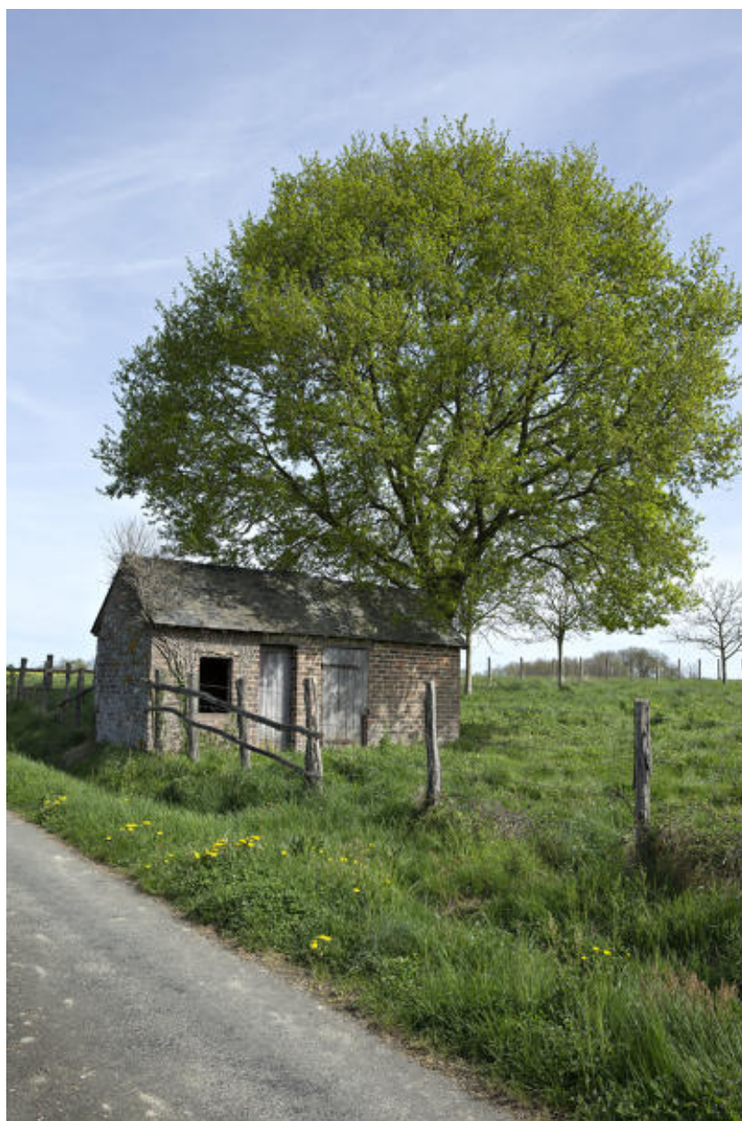
Ruillé-sur-Loir : maison de vigne.
