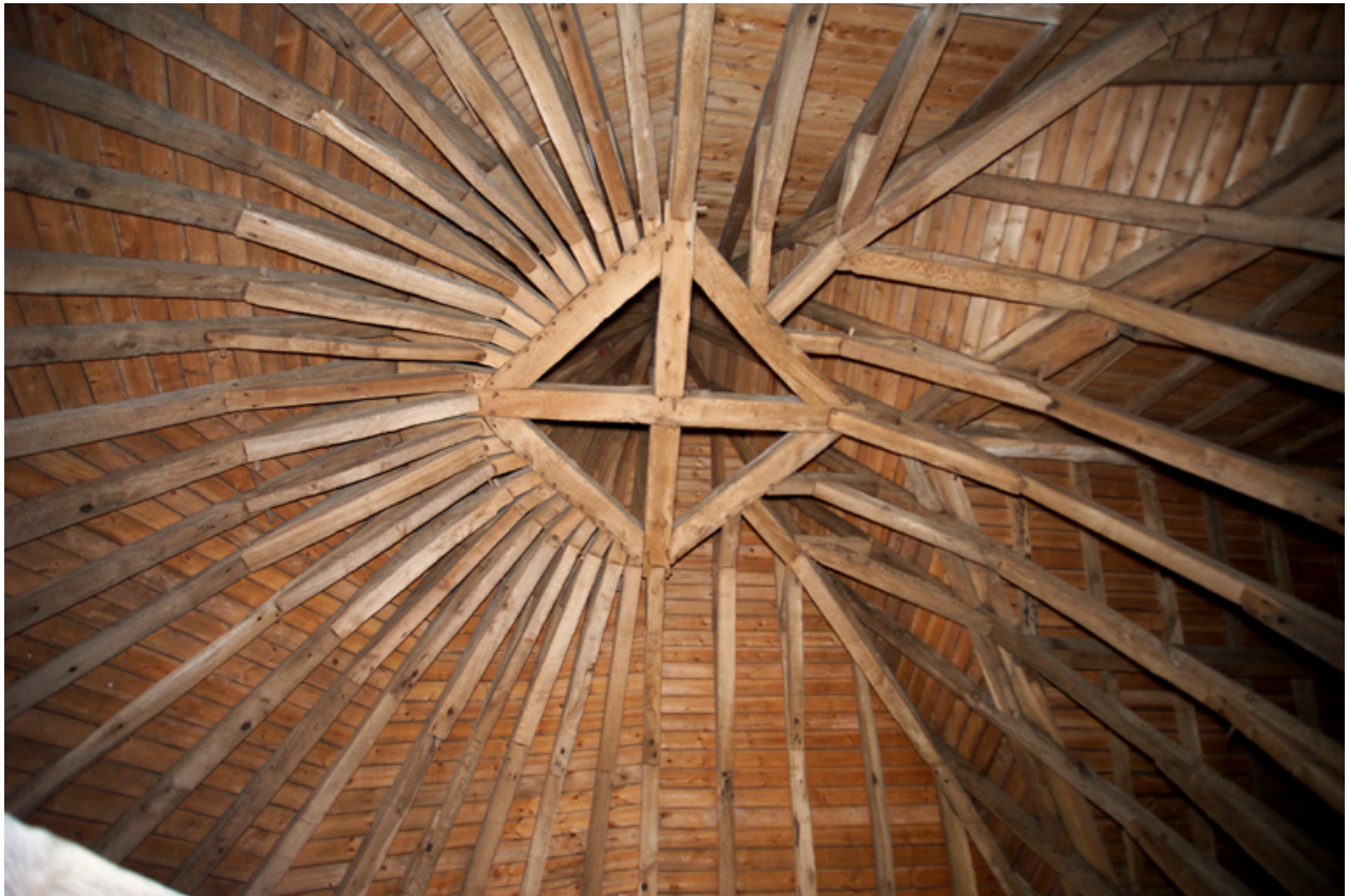
Vue de la charpente, couverture de tour.
