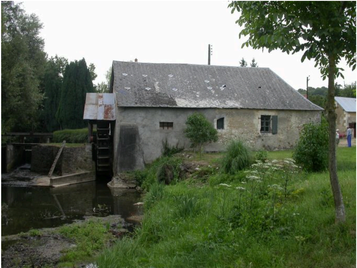
Vue d'ensemble prise en aval.
