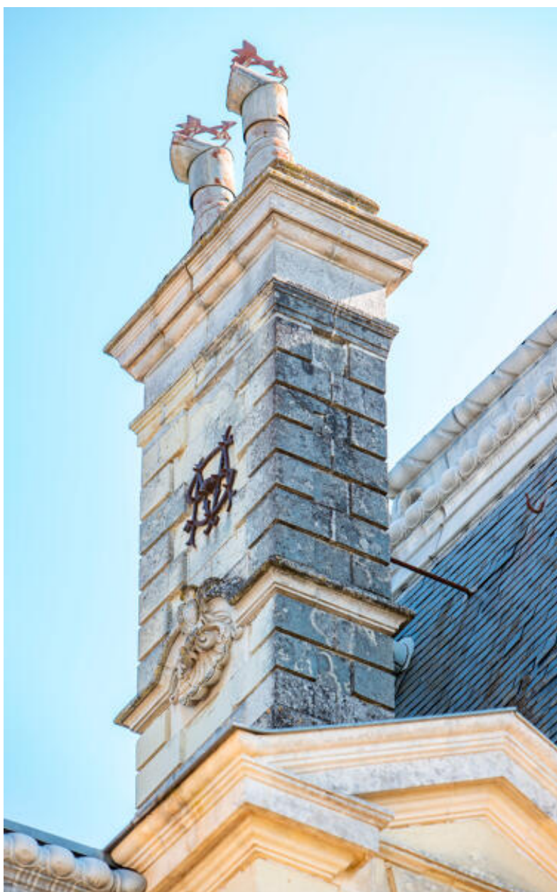
Le pavillon sud-est, souche de cheminée.
