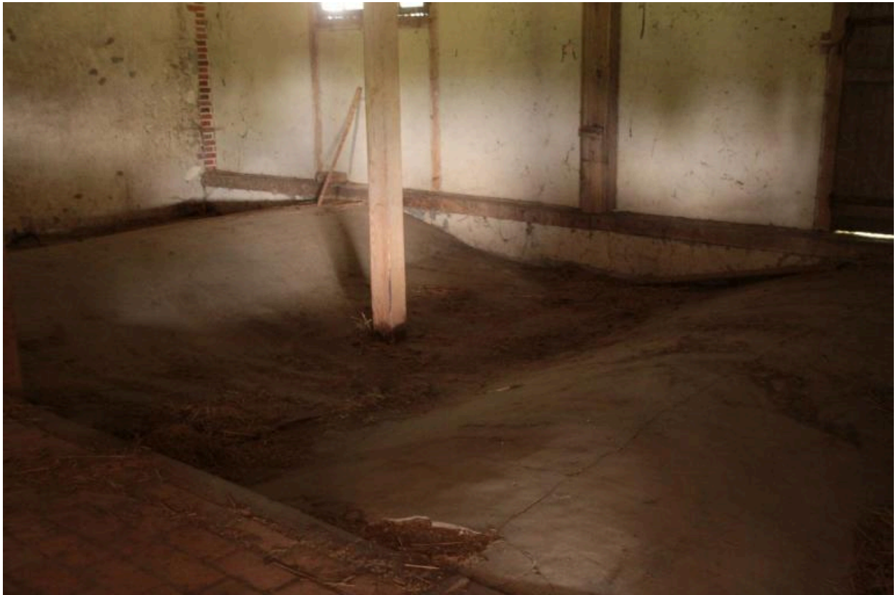
Vacherie, bâtiment d'habitation : détail à l'étage.
