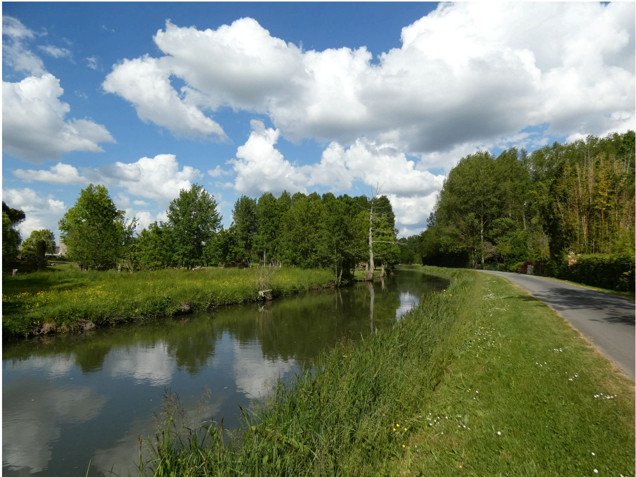
La rigole de la Rive droite en aval de la Poublée, en direction de l'est.
