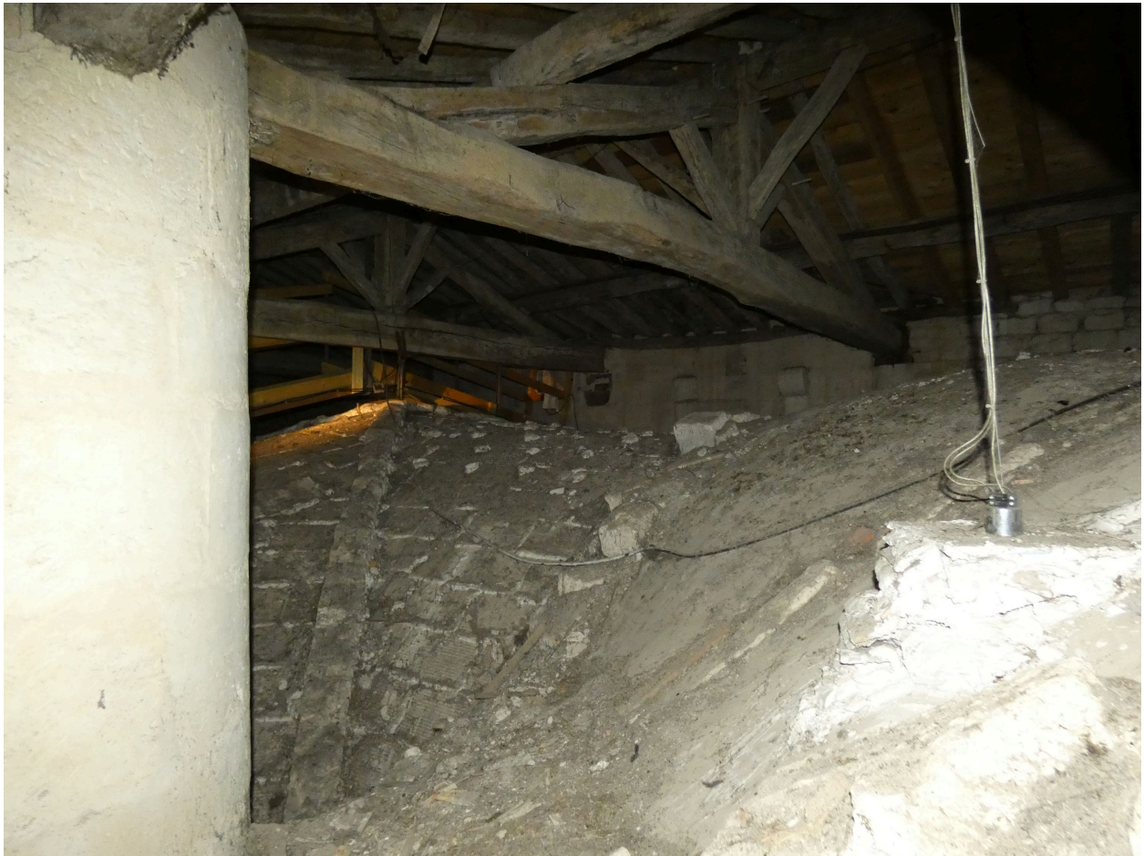
Voûtes en briques de la nef.
