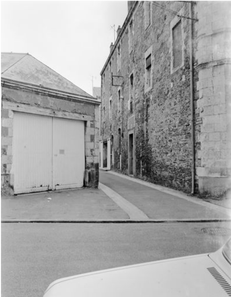
Aile orientale du cloître : vestiges de l'élévation est sur l'actuelle impasse Grainetière.
