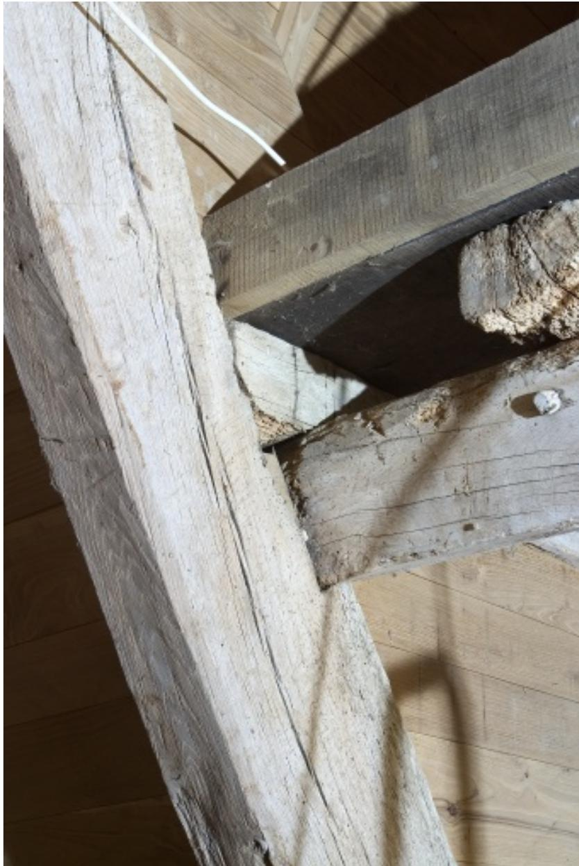
Intérieur du logis, comble. Détail de la charpente : arbalétrier et panne intermédiaire du comble principal, poutre du plancher de l'ouverture situé entre la salle de la tour et le comble principal.
