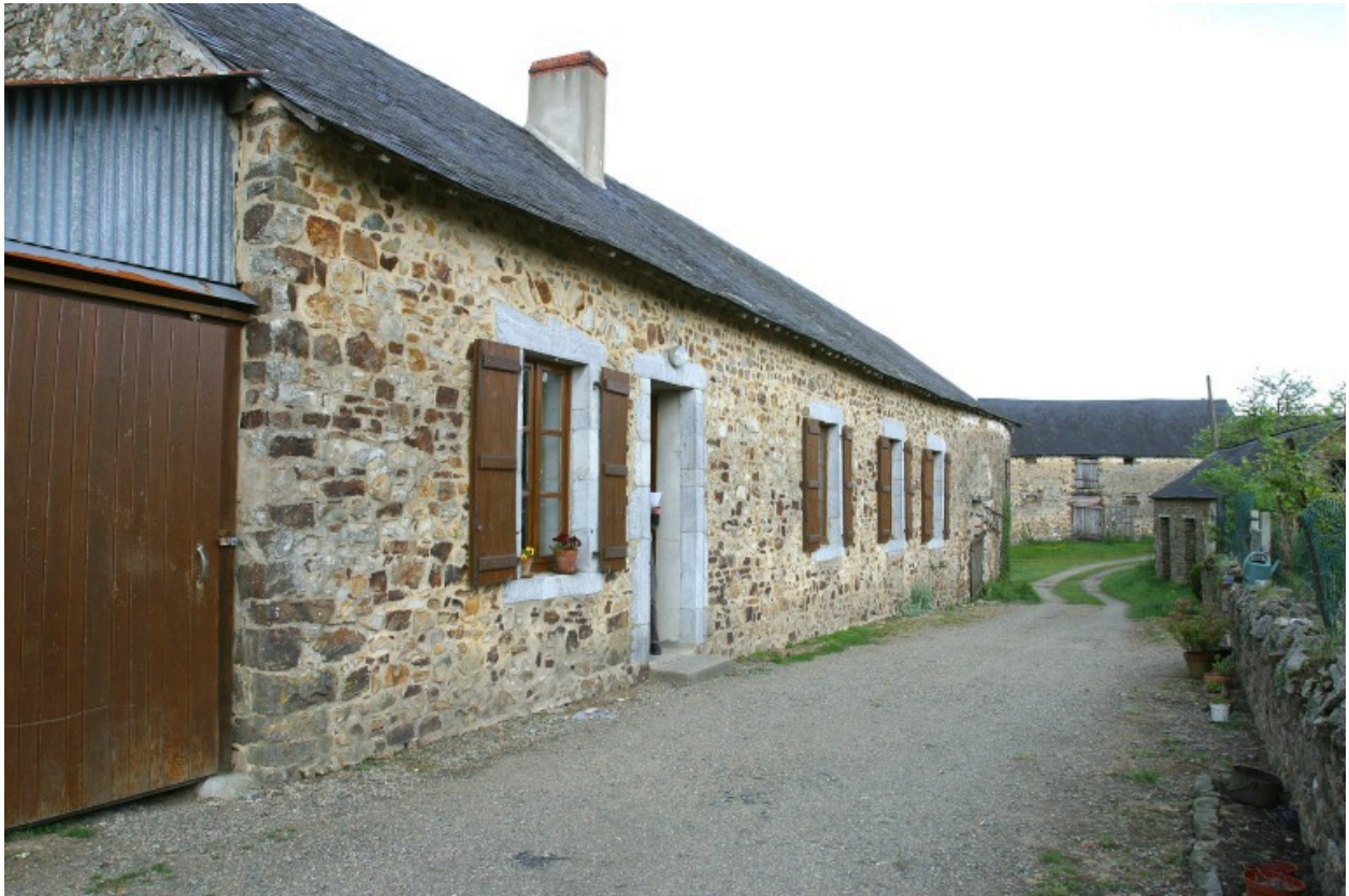
Le logis-étable à chevaux de la ferme vu depuis l'ouest. Au fond, la façade principale de l'étable.
