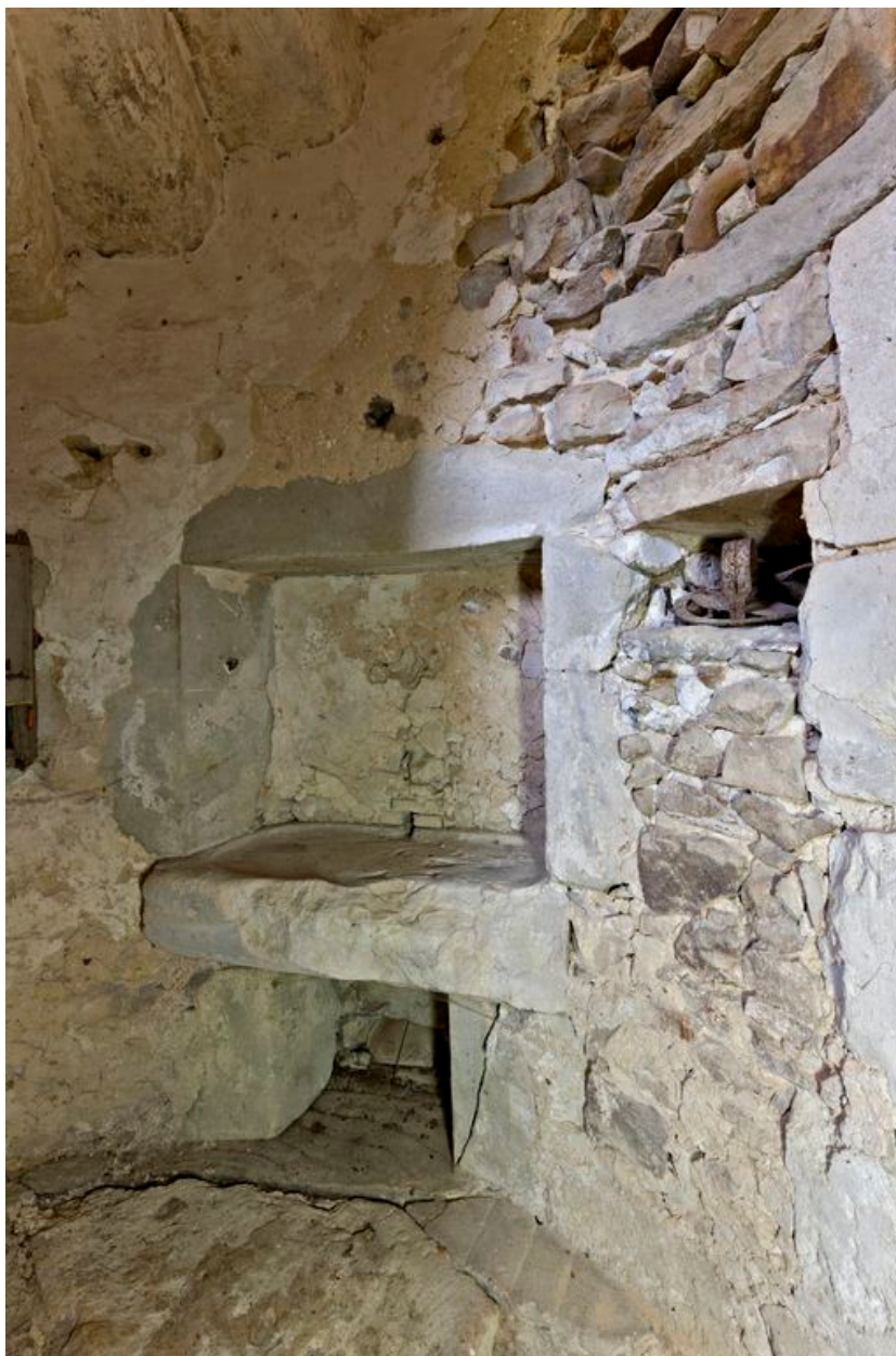
Evier au rez-de-chaussée de la tour d'escalier.
