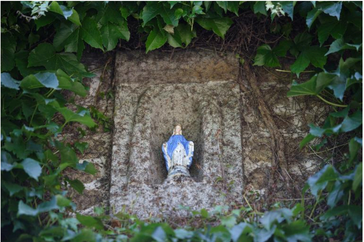
Détail de la façade principale du moulin : la niche portant la date de 1891.
