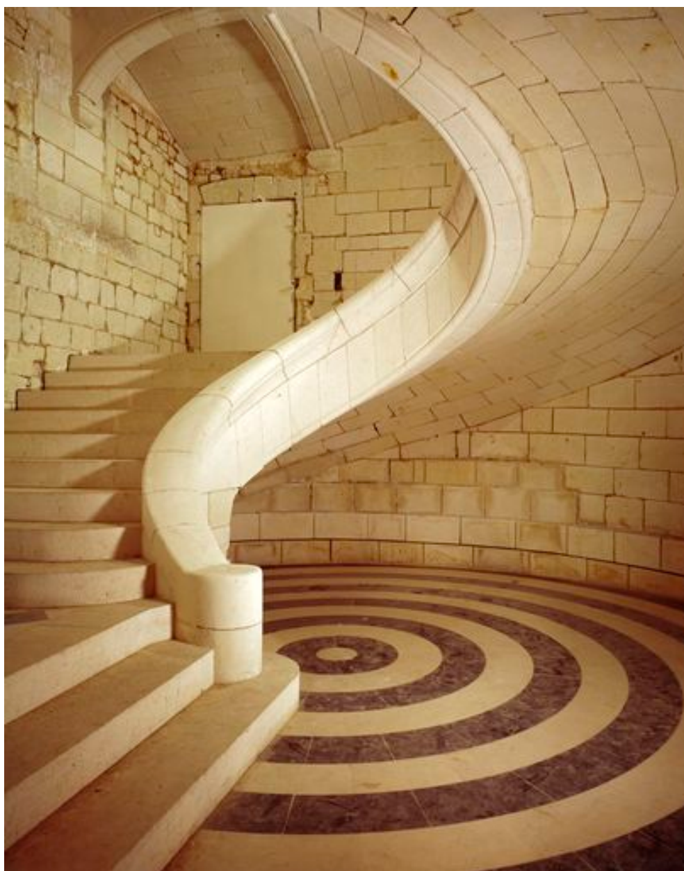
Prieuré Saint-Lazare, escalier tournant à jour (en 1977, avant restauration).
