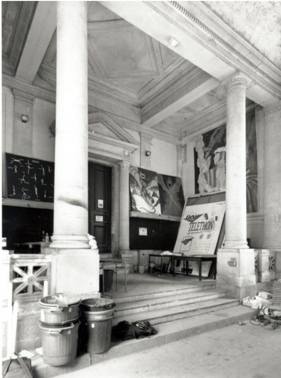
Bâtiment des études et de la salle de distribution des prix (par Isabelle, Ch.-E.), passage couvert, face est : vestibule d'accès à la salle.
