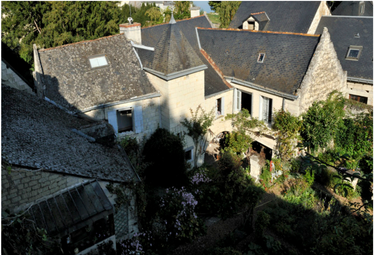
Vue générale, depuis la Haute rue.
