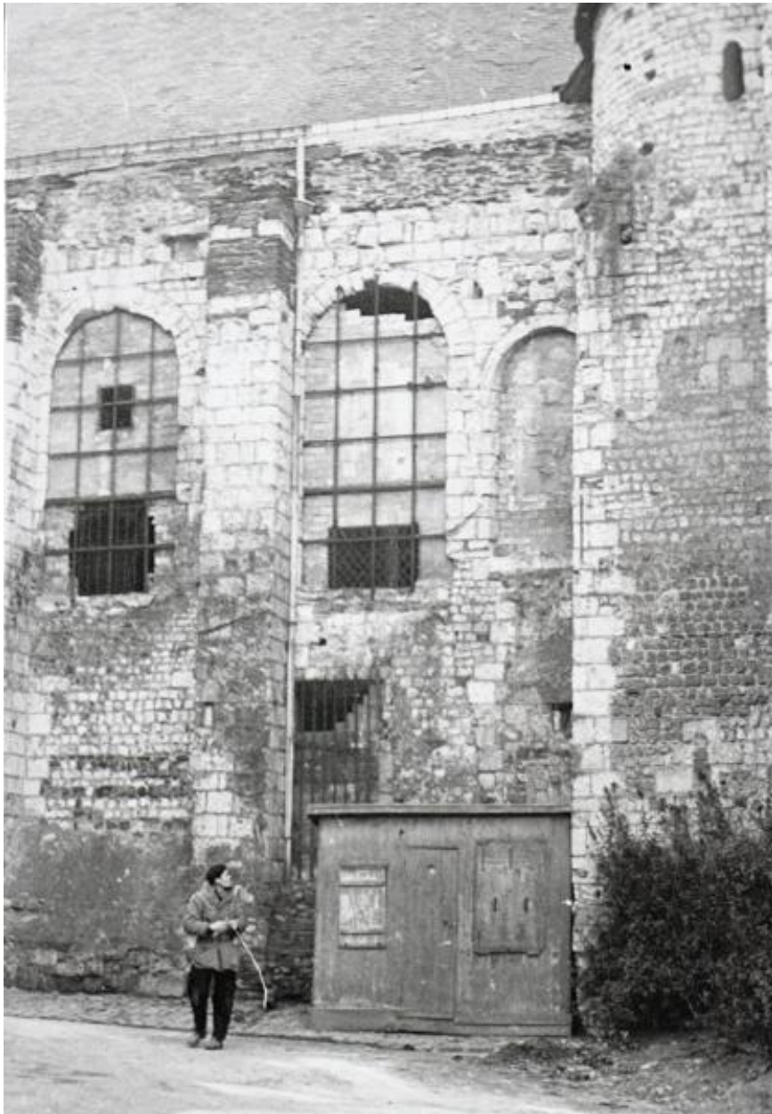
Eglise abbatiale, élévation extérieure sud : détail sur les baies orientales jouxtant la tour d'escalier contre le transept, fotogr., de H. Enguehard, [v. 1960]. (Coll. part., Henri Enguehard).
