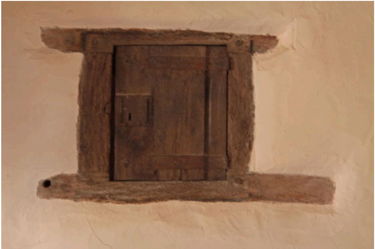
Maison, placard mural à droite de la cheminée.
