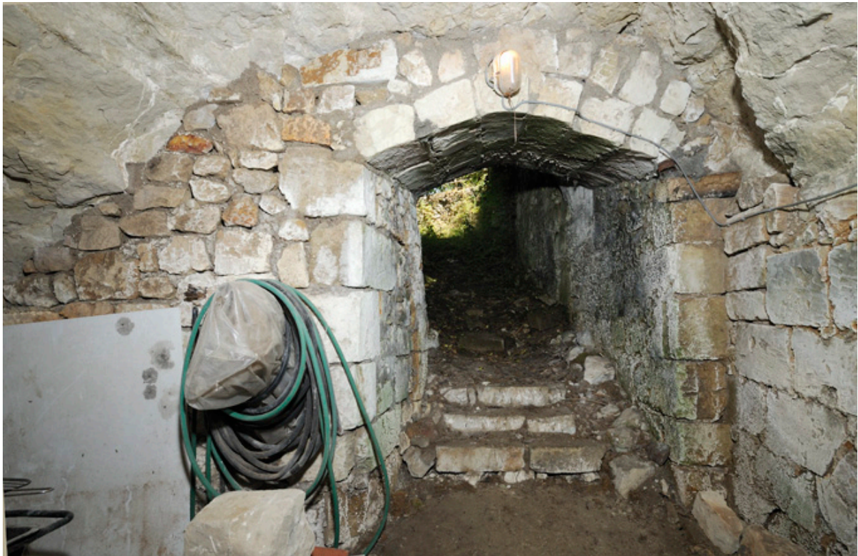
Première travée (mur nord) : vue sur l'entrée avec vestibule grossièrement voûté.
