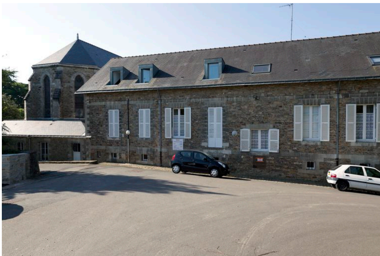
2 : infirmerie, façade nord.
