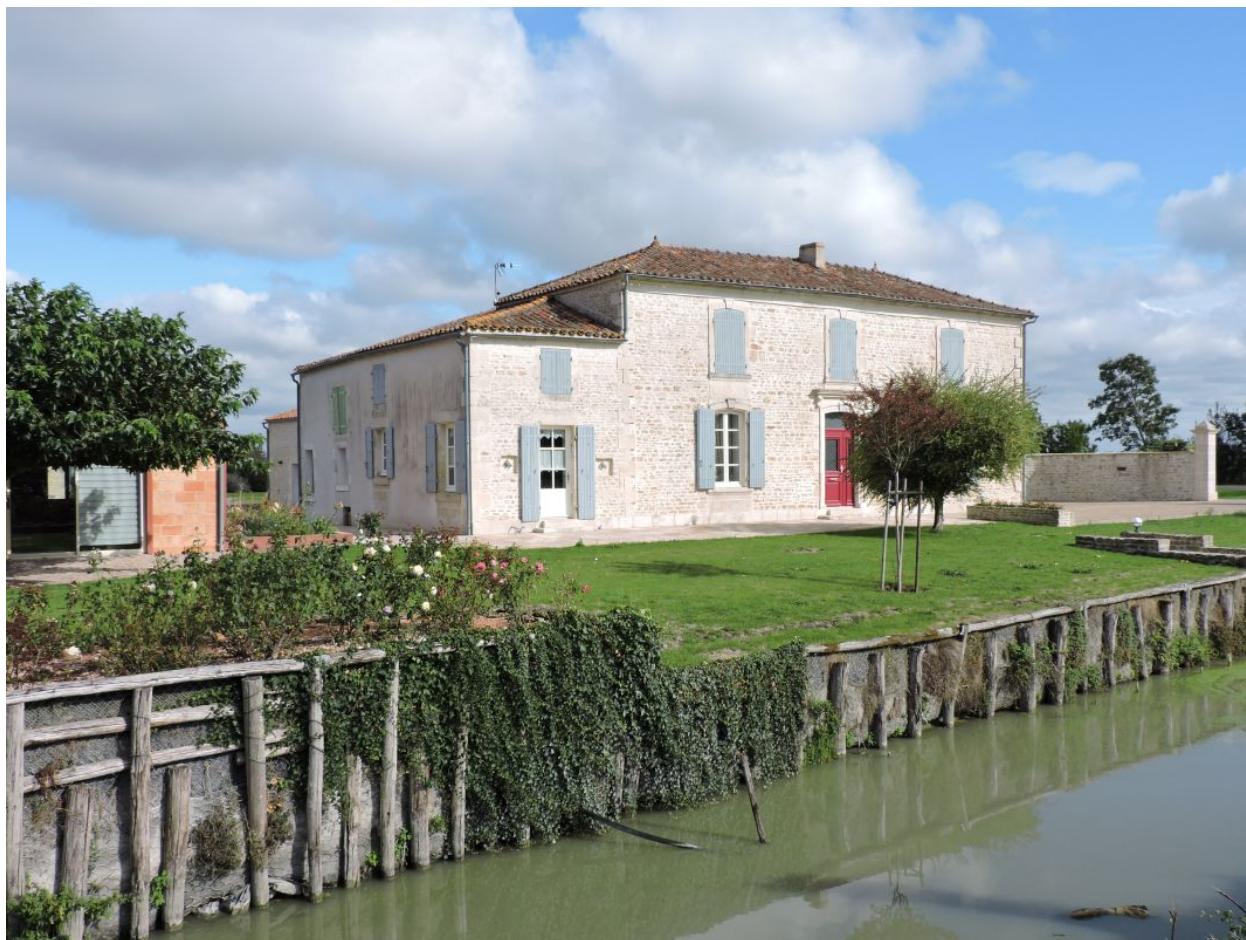
Le logis et son aile ouest vus depuis le sud-ouest.
