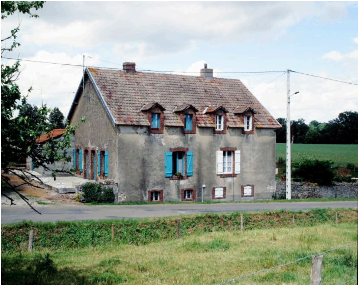
Maisons ouvrières jumelles situées route de Rochefort : façade sur rue.
