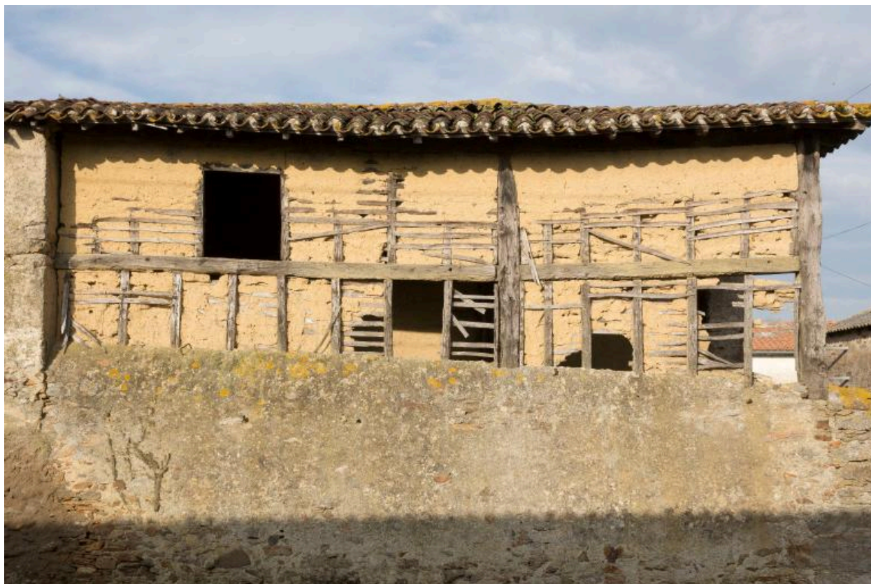
Bâtiment avec cloison en torchis. La Mauvillonnière, La Planche, cadastre 2018, YA 01-187
