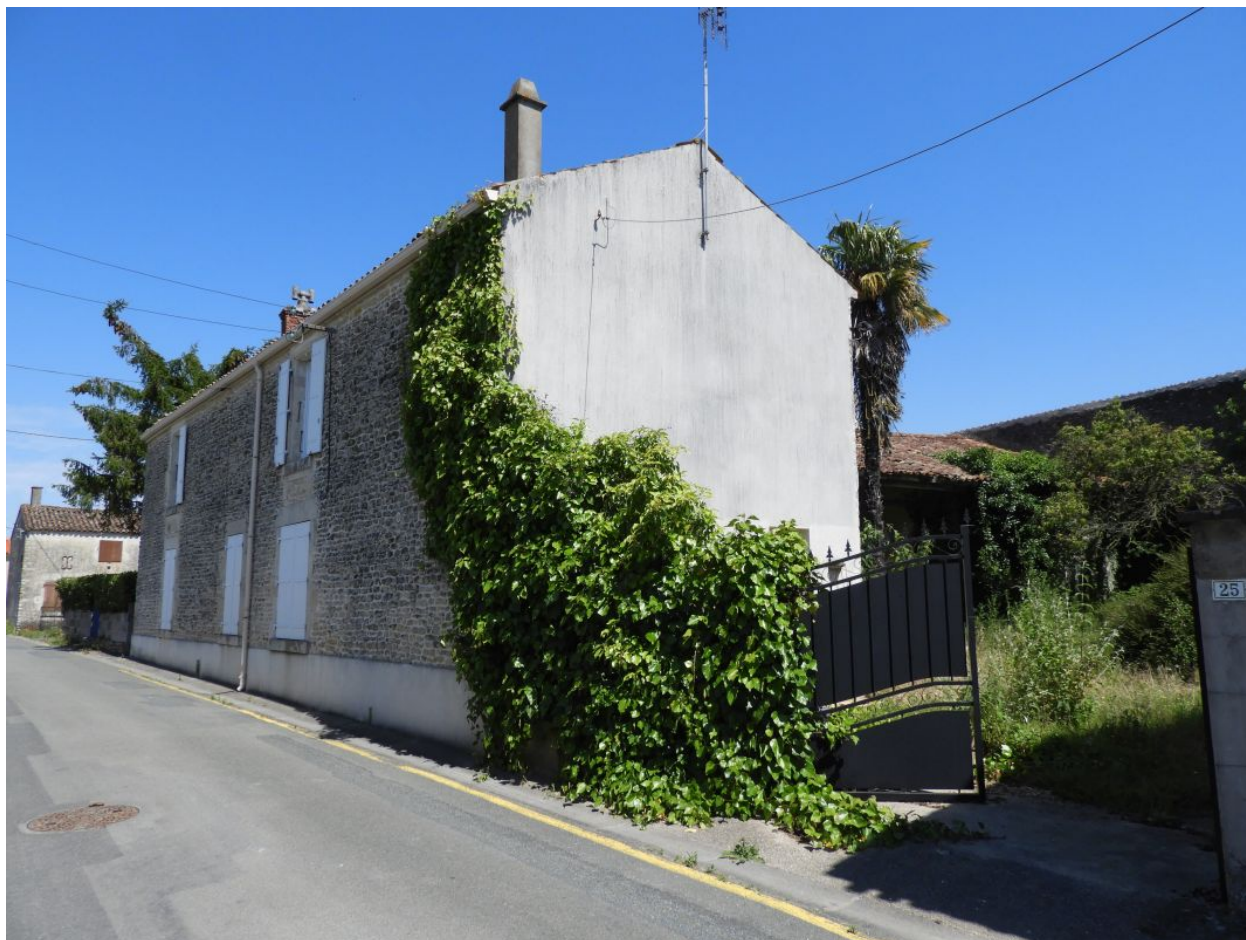
La maison vue depuis le sud-est.
