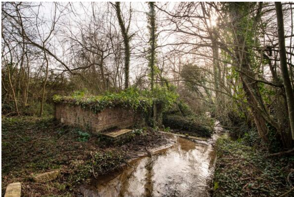
Station de captage depuis l'amont : lavoir et bâtiment du bassin de décantation.
