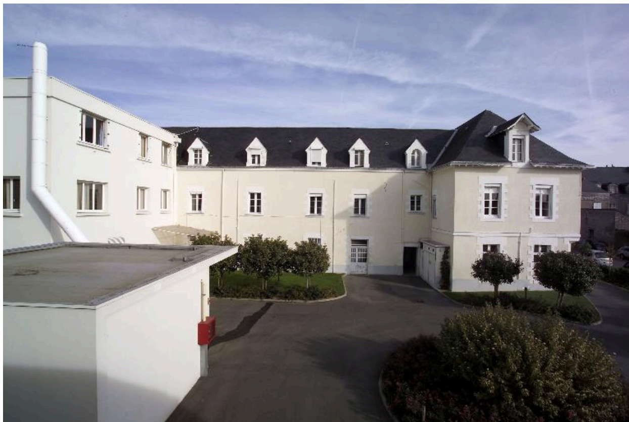
La façade sud, partie est.
