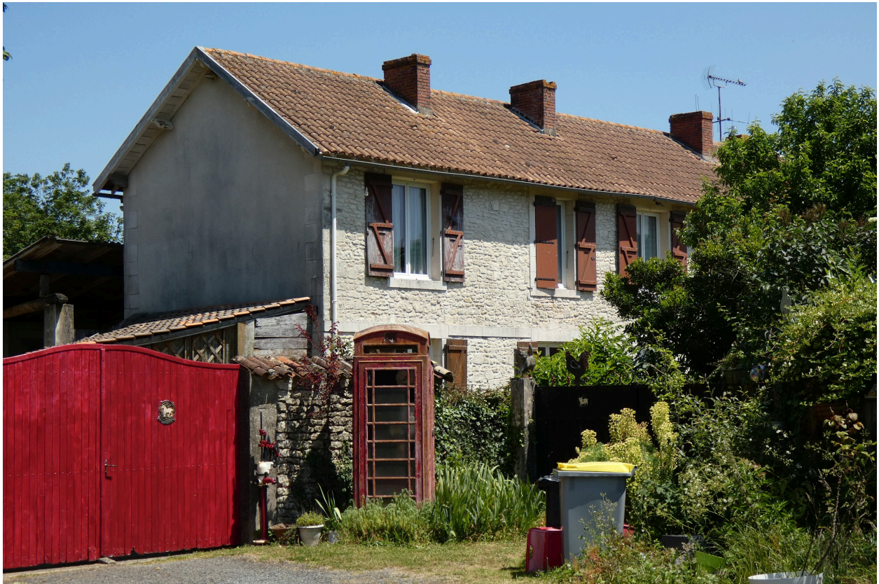
Anciens bureaux administratifs vus depuis le nord-ouest.
