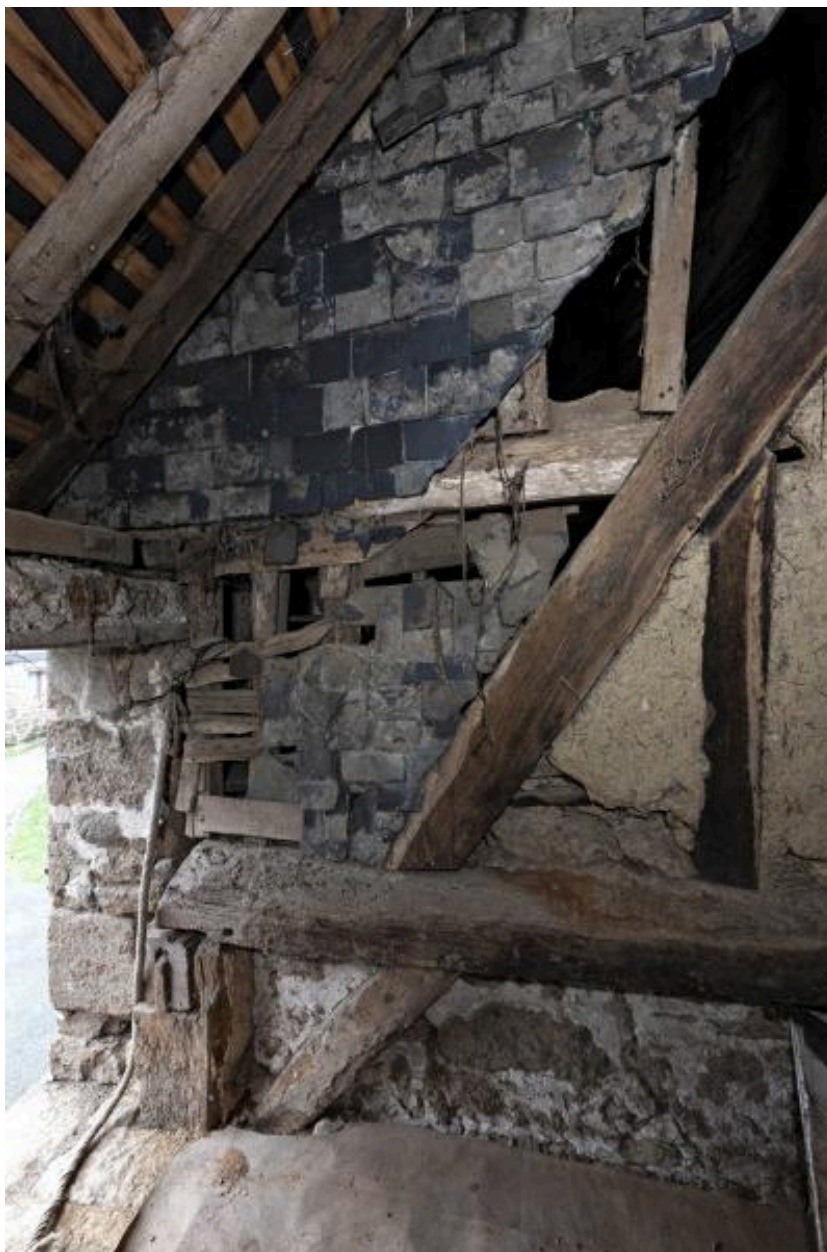
Ferme de charpente entre le comble de la maison et celui du cellier, détail de l'assemblage aisselier, poteau, lien.
