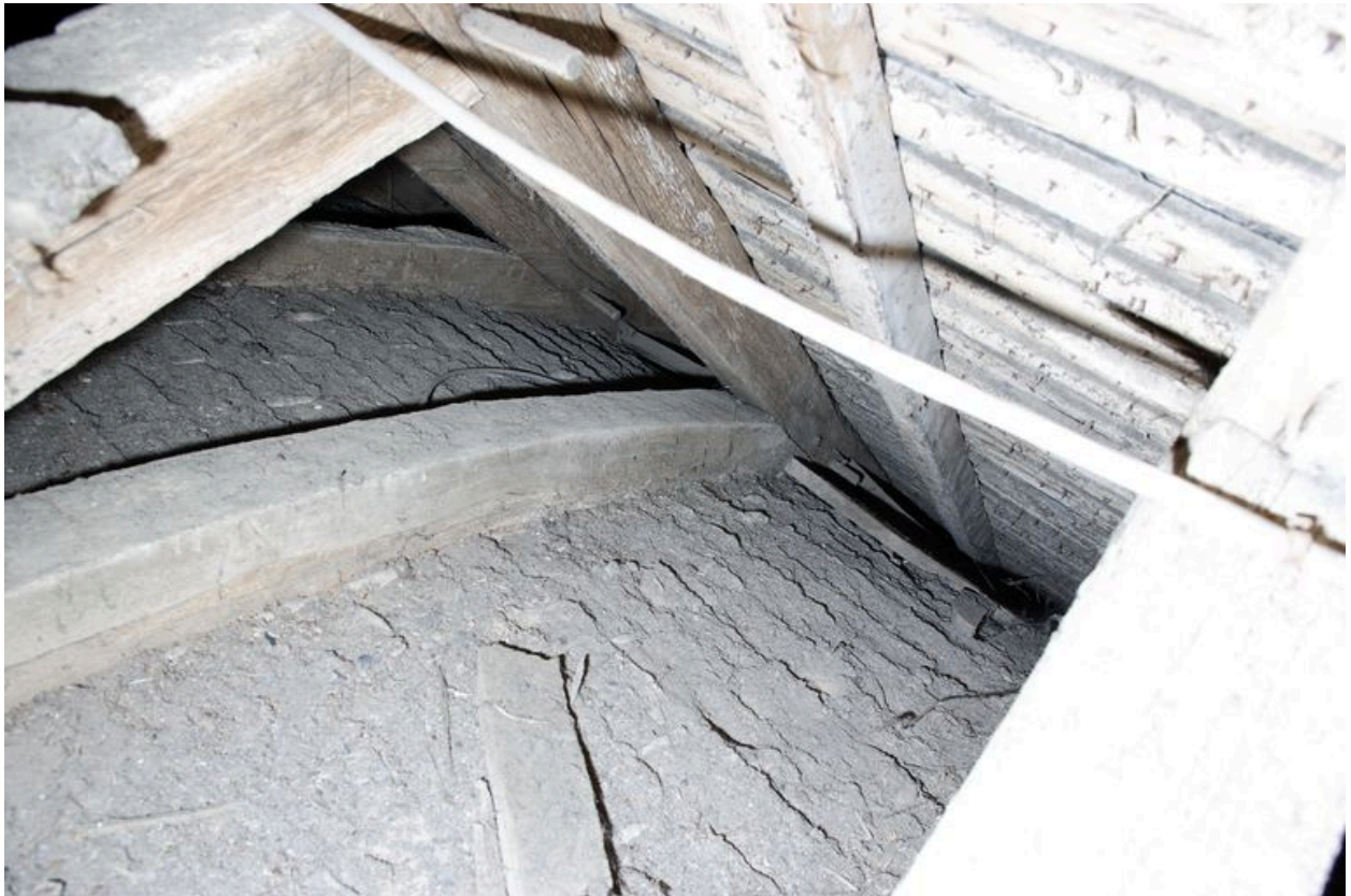
Charpente de la nef. Vue partielle de la partie sud d'une ferme : chevron, faux-entrait, aisselier.
