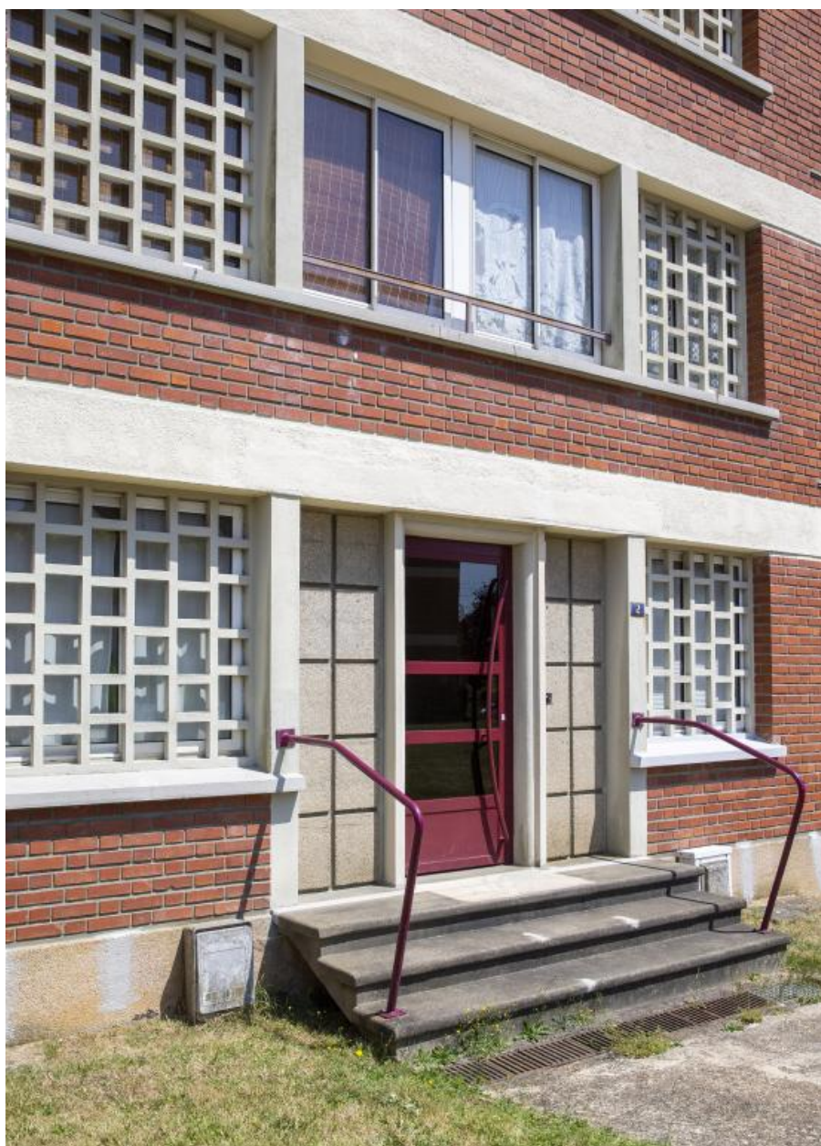
Vue de l'entrée du bâtiment D4 depuis les espaces verts.
