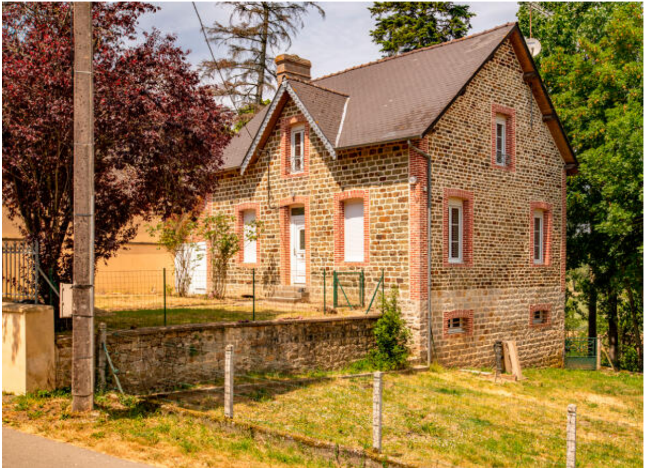
Ecart du Pont de Couterne, maison (ZE 109).
