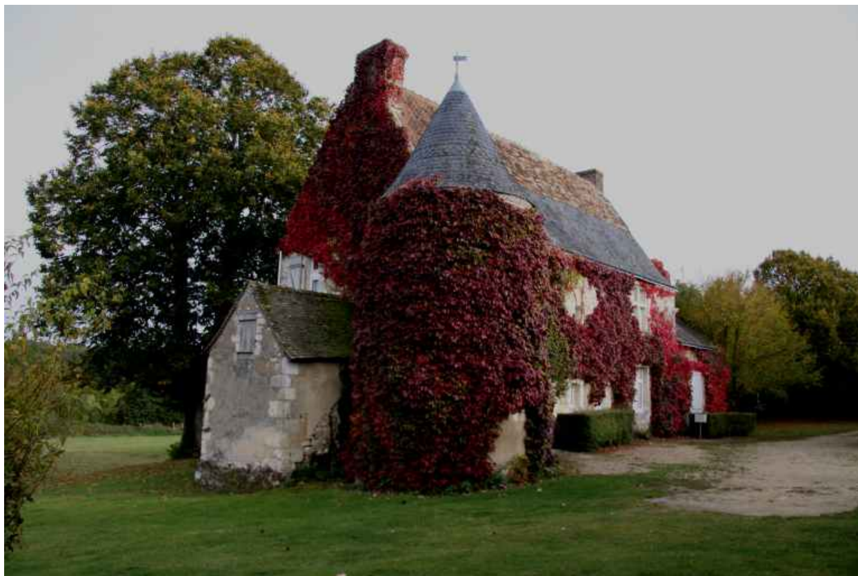
Le logis, vue de volume prise du nord : tourelle d'angle.
