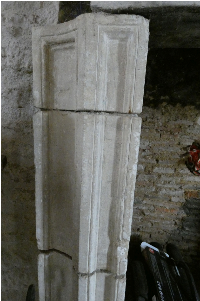
Détail d'une cheminée à l'intérieur du logis : montant mouluré.
