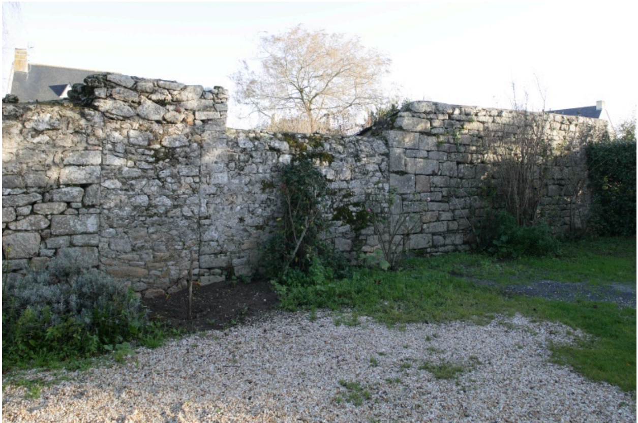
Porte murée dans le mur séparant les parcelles AH 360 et AH 219, vue vers le Nord.
