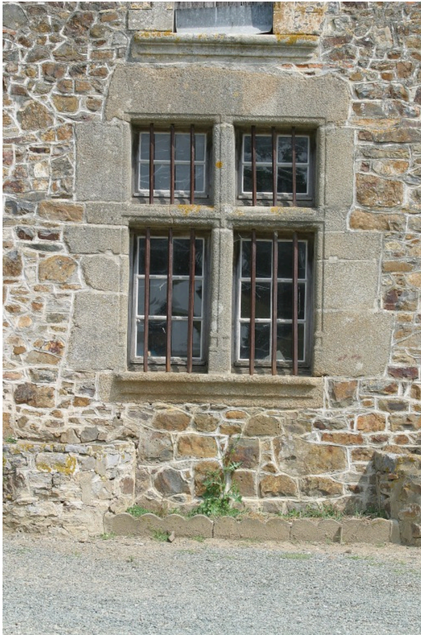
Le logis. Détail de l'élévation principale : la croisée du rez-de-chaussée.
