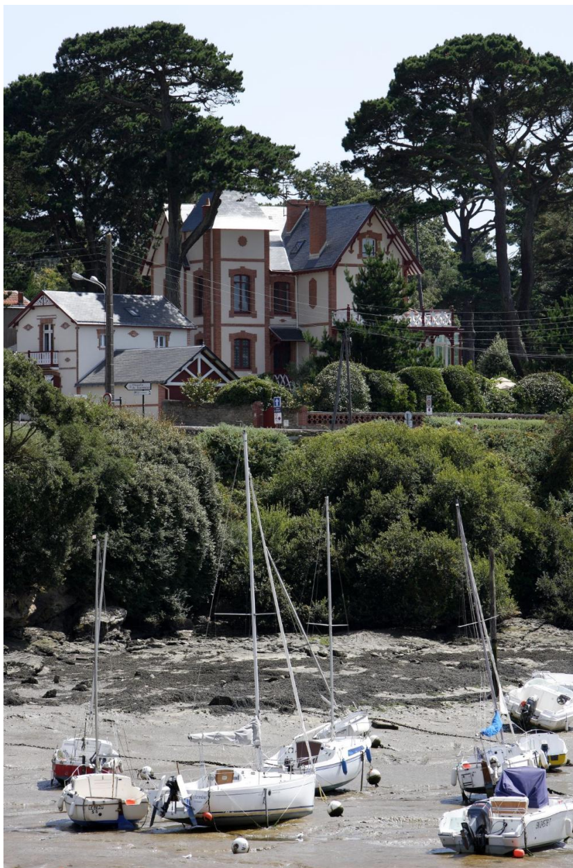
Vue d'ensemble de la villa.
