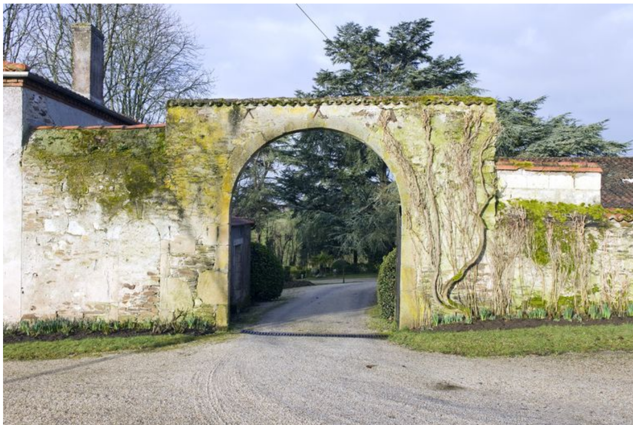
Le portail et sa porte de service murée. Fin 17 e siècle.
