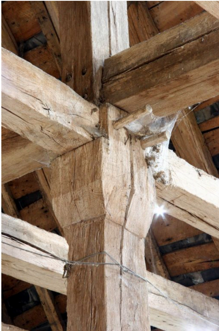
La charpente de récupération : détail de l'assemblage du faux entrain.
