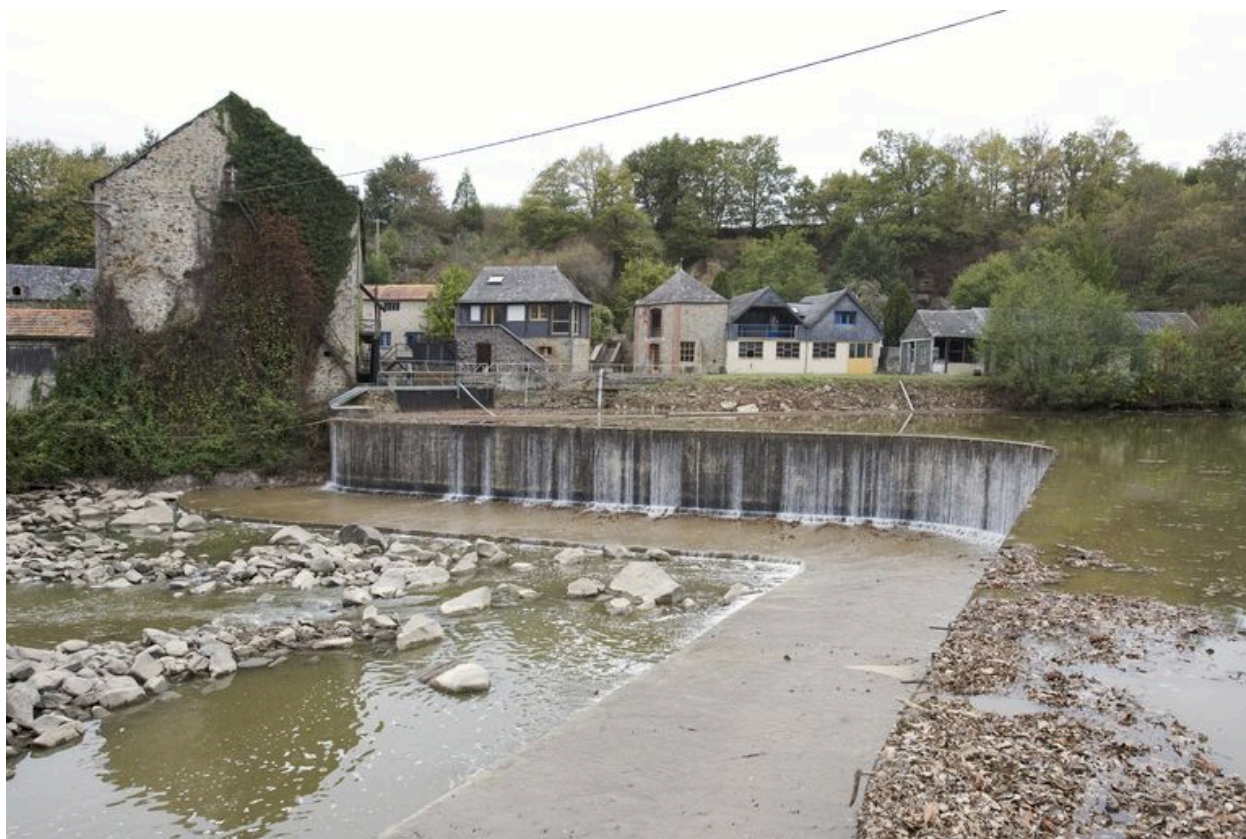
Ensemble des bâtiments nord de l'ancienne usine, vus depuis la rive gauche, pendant les écoures de 2009.
