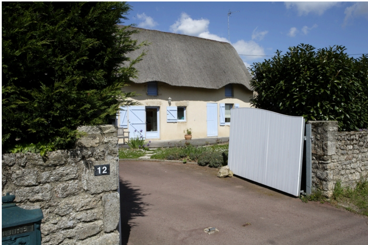
Vue depuis le sud-ouest.
